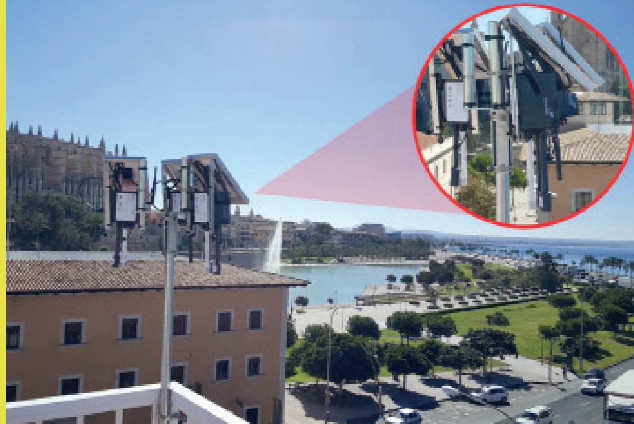
Figura 2. Sensor Ambiental IoT instalado en Sede Autoridad Portuaria de Palma
