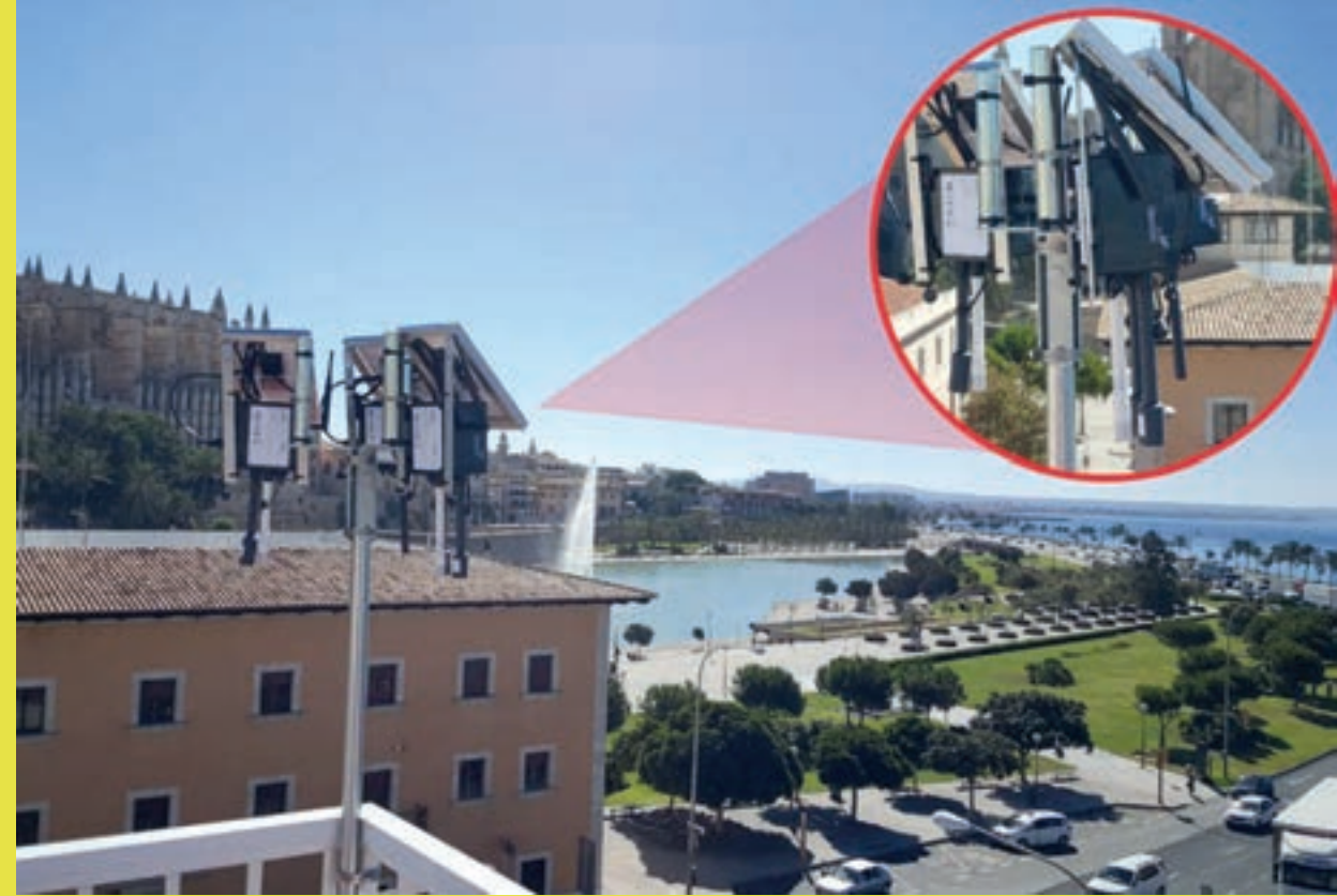
Abbildung 2. Installierter IoT-Umgebungssensor im Hauptsitz der Hafenbehörde von Palma
