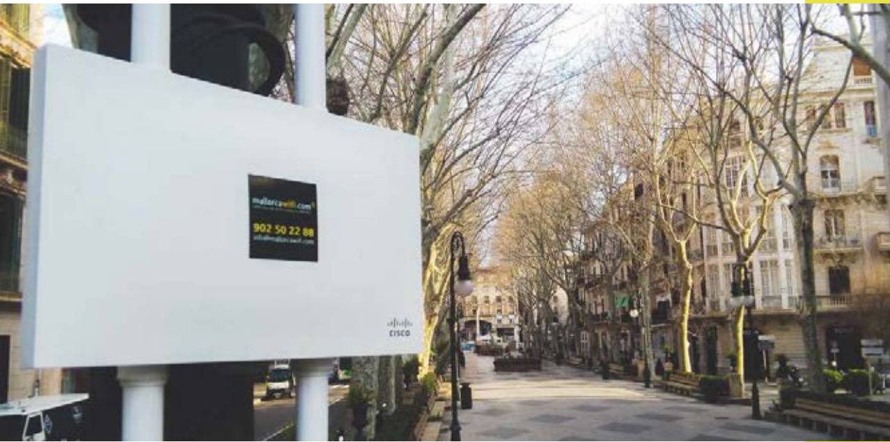
Abbildung 1. Installierter WLAN-Zugangspunkt im Paseo del Borne de Palma
